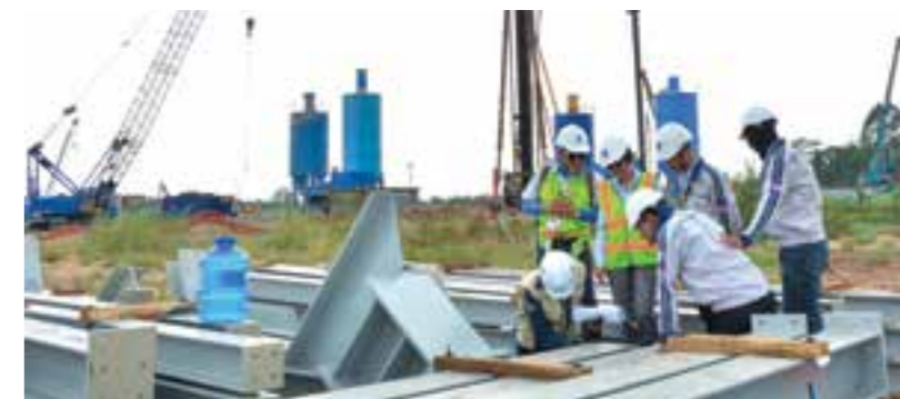
Trên công trường Dự án Điện lực Dầu khí Sông Hậu 1
