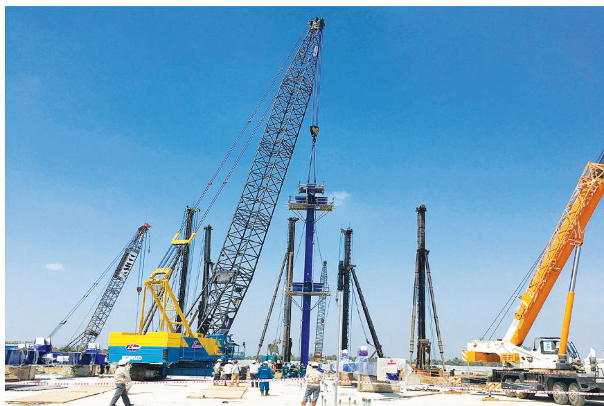
Công trường Dự án Nhà máy Nhiệt điện Long Phú 1
