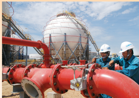
Lắp đặt đường ống dẫn khí tại Kho cảng Thị Vải
