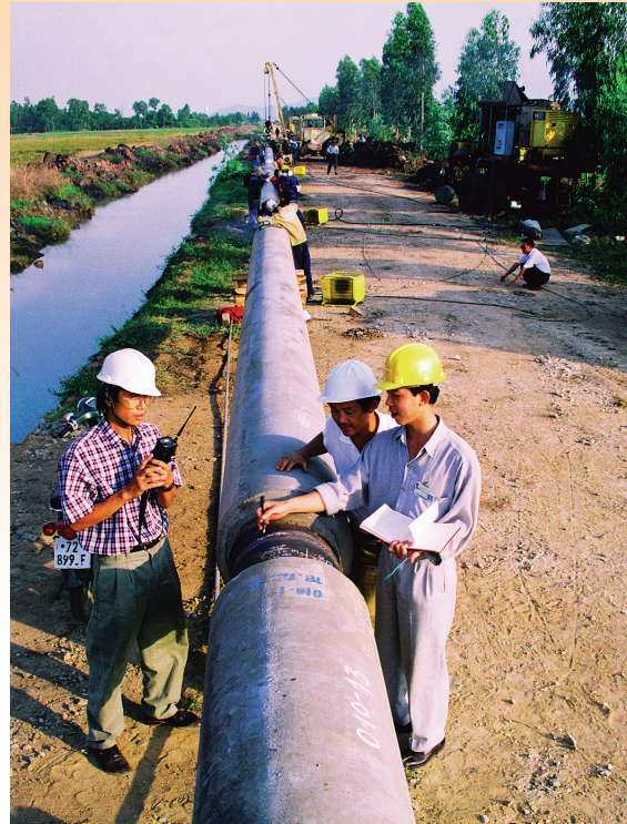
Xây lắp đường ống dẫn khí Nam Côn Sơn
