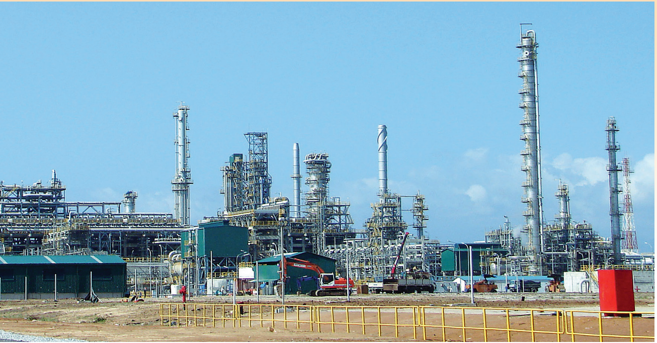
Toàn cảnh Nhà máy Lọc dầu Dung Quất
