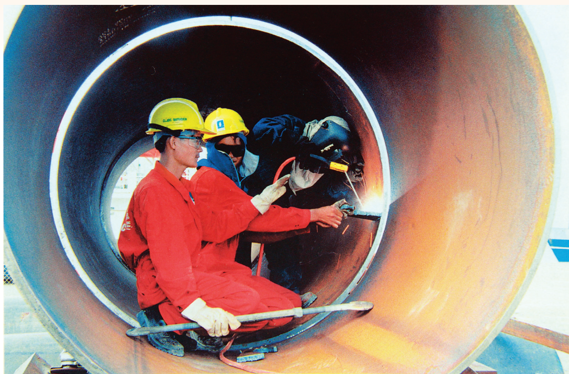
Các kỹ sư đang xây lắp đường ống dẫn khí từ Bà Rịa đến Phú Mỹ
