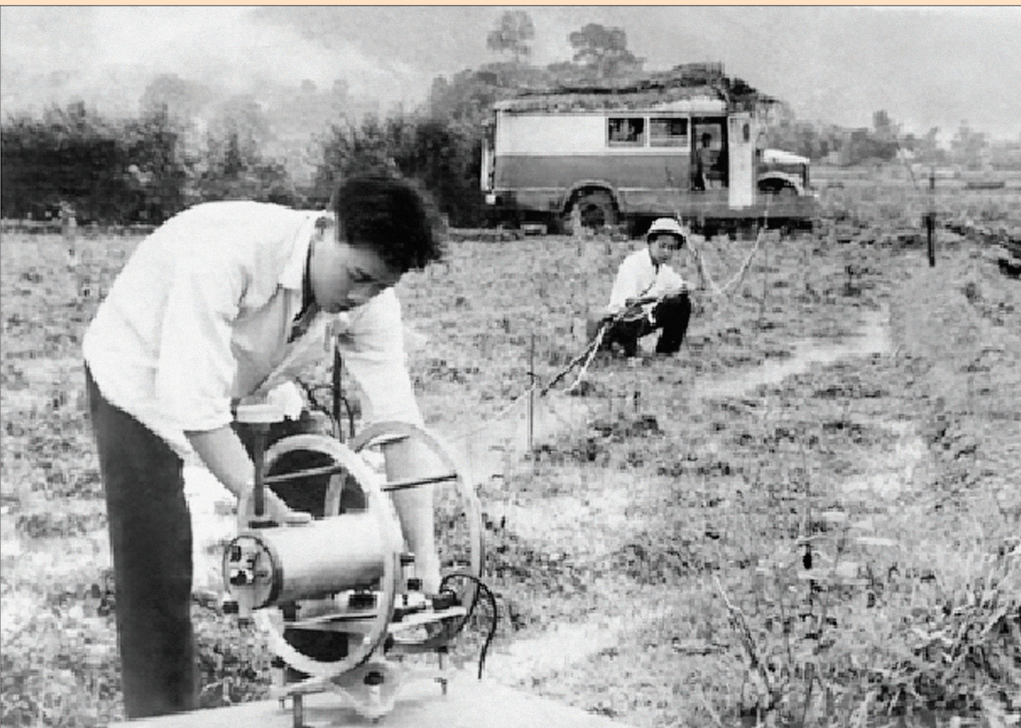
▲ Rải dây tiến hành phương pháp đo điện từ (telua) ở khu vực miền vống Hà Nội
