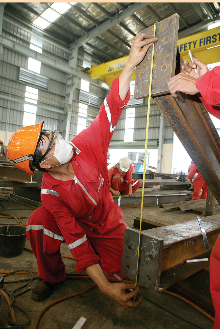
▲ Kỹ sư lắp đặt thiết bị cho nhà giàn tại xí nghiệp xây lắp
