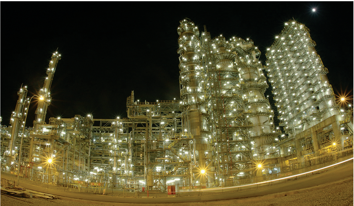
Nhà máy Lọc dầu Dung Quất về đêm
