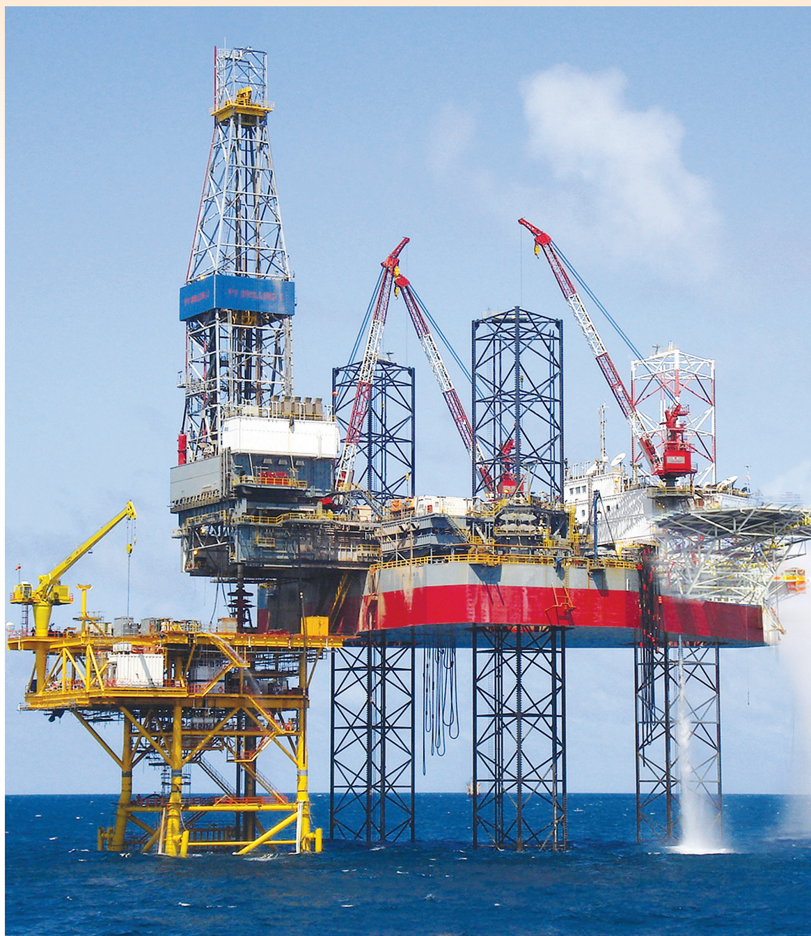
Giàn khoan PV Drilling I
