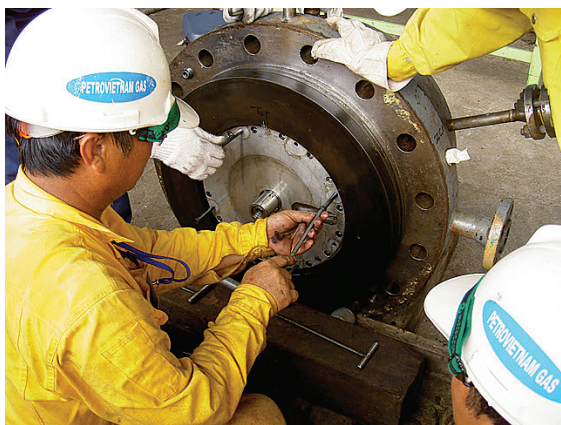
Bảo dưỡng van đường ống dẫn khí
