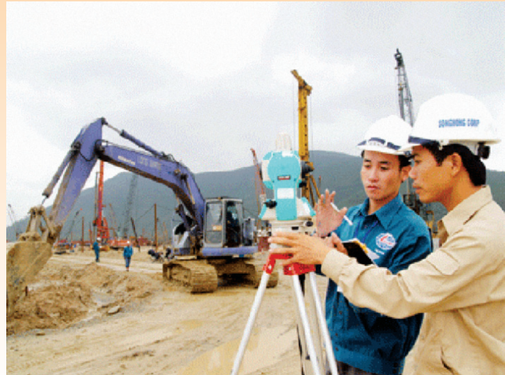
Trên Công trường Nhà máy Nhiệt điện Vũng Áng 1
