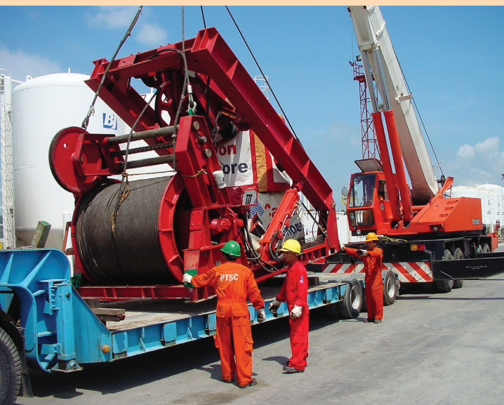
Lắp đặt thiết bị siêu trường siêu trọng của PTSC
