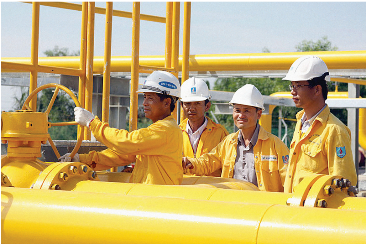
Kiểm tra đường ống dẫn khí tại Nhà máy Khí Dinh Cố
