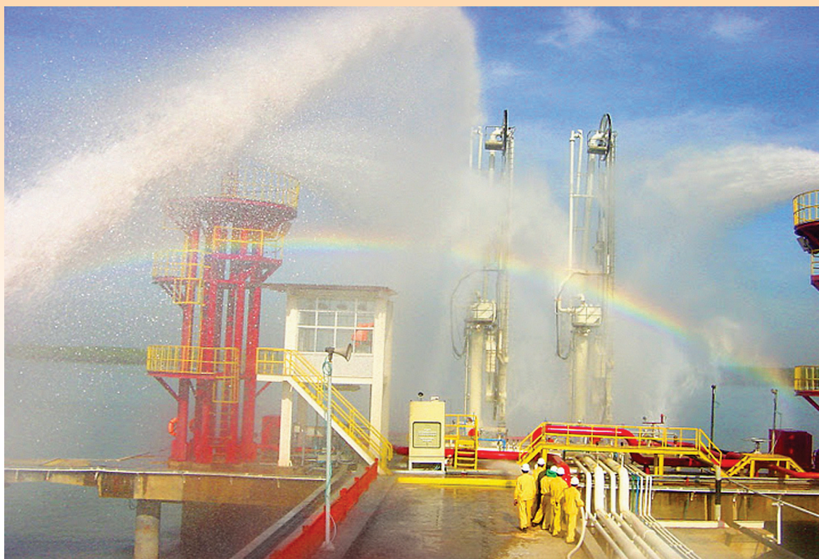
Diễn tập phòng cháy chữa cháy tại Kho cảng Thị Vải
