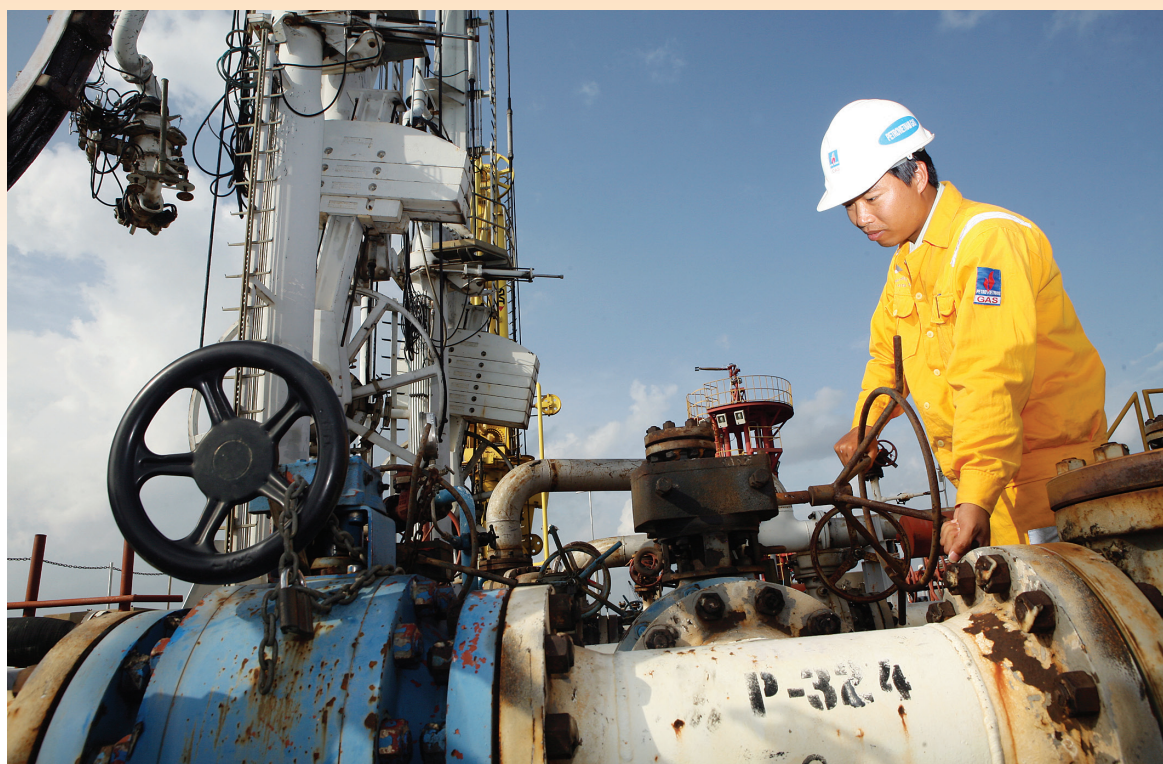
Kỹ sư kiểm tra đường ống dẫn khí
