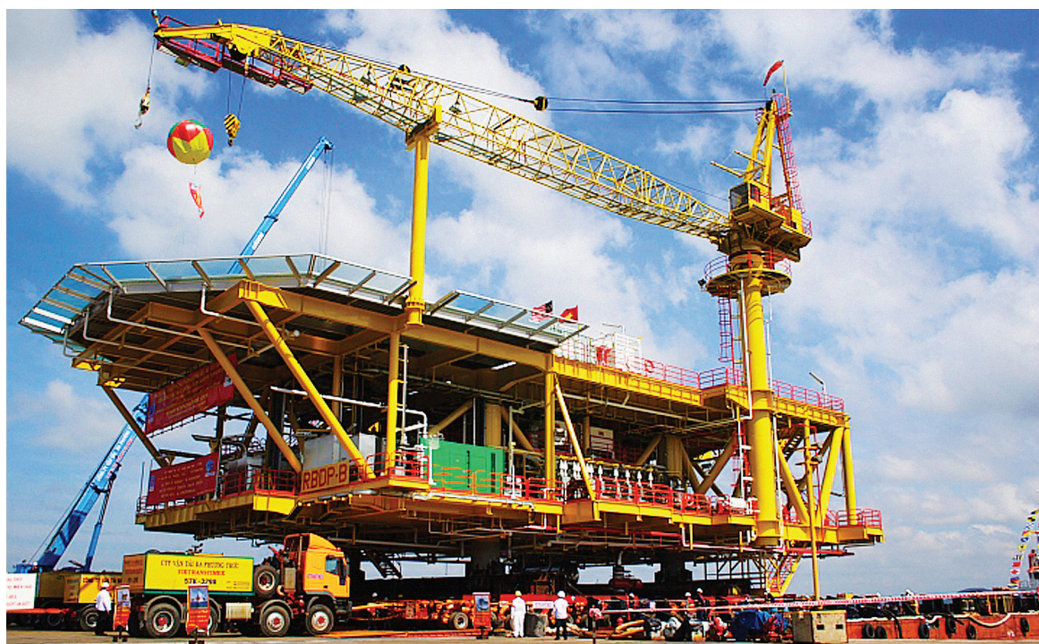
Nhà giàn của PTSC đang trong quá trình hoàn thiện
