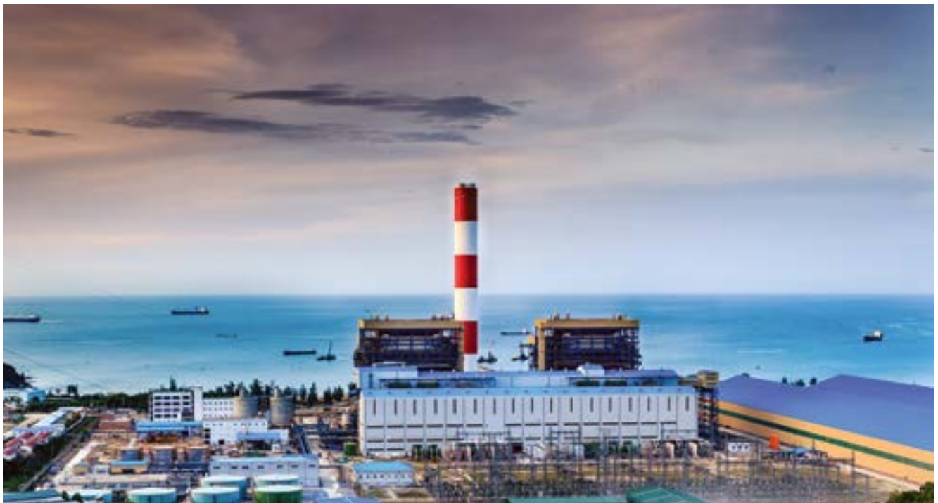
Nhà máy Nhiệt điện Vũng Áng 1
