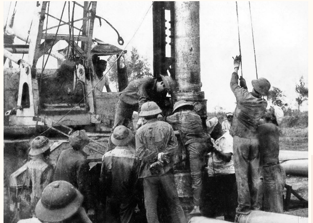
Xây lắp chân đế giàn khoan dầu khí ở Tiên Hưng - Thái Bình
