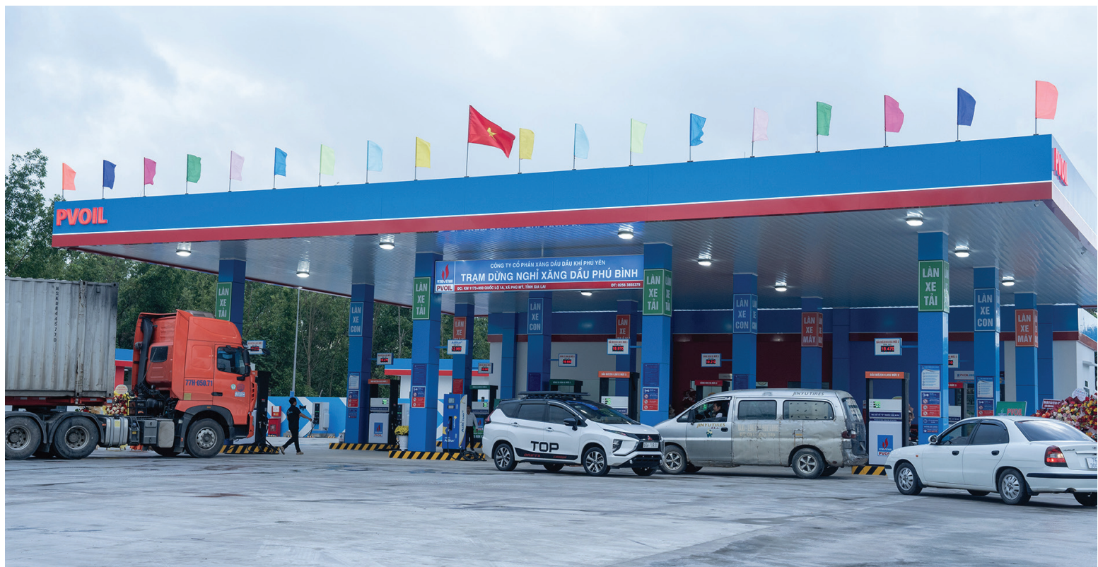
Trạm dừng nghỉ xăng dầu Phú Bình nằm trên quốc lộ 1A, trực giao thông huyết mạch nối liền Bắc - Nam.
