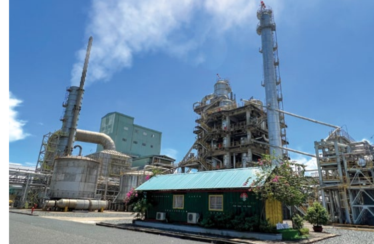
Cụm tạo hạt tầng sôi của Nhà máy Đạm Cà Mau
