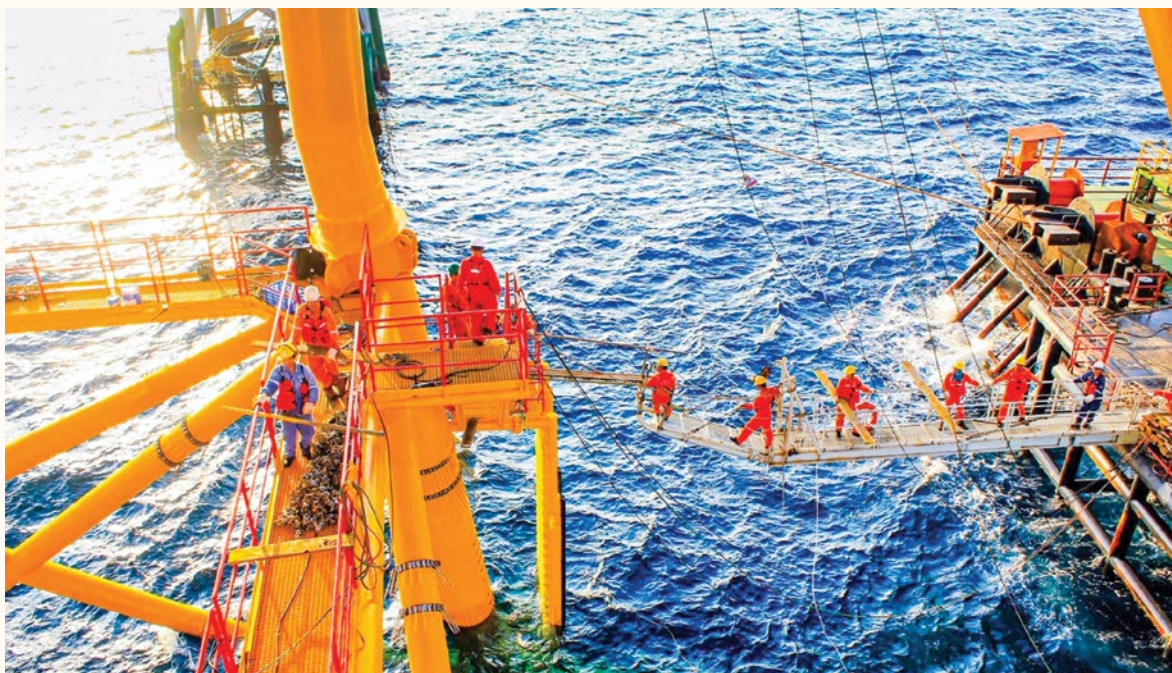
Người lao động dầu khí bảo dưỡng giàn khoan trên biển
