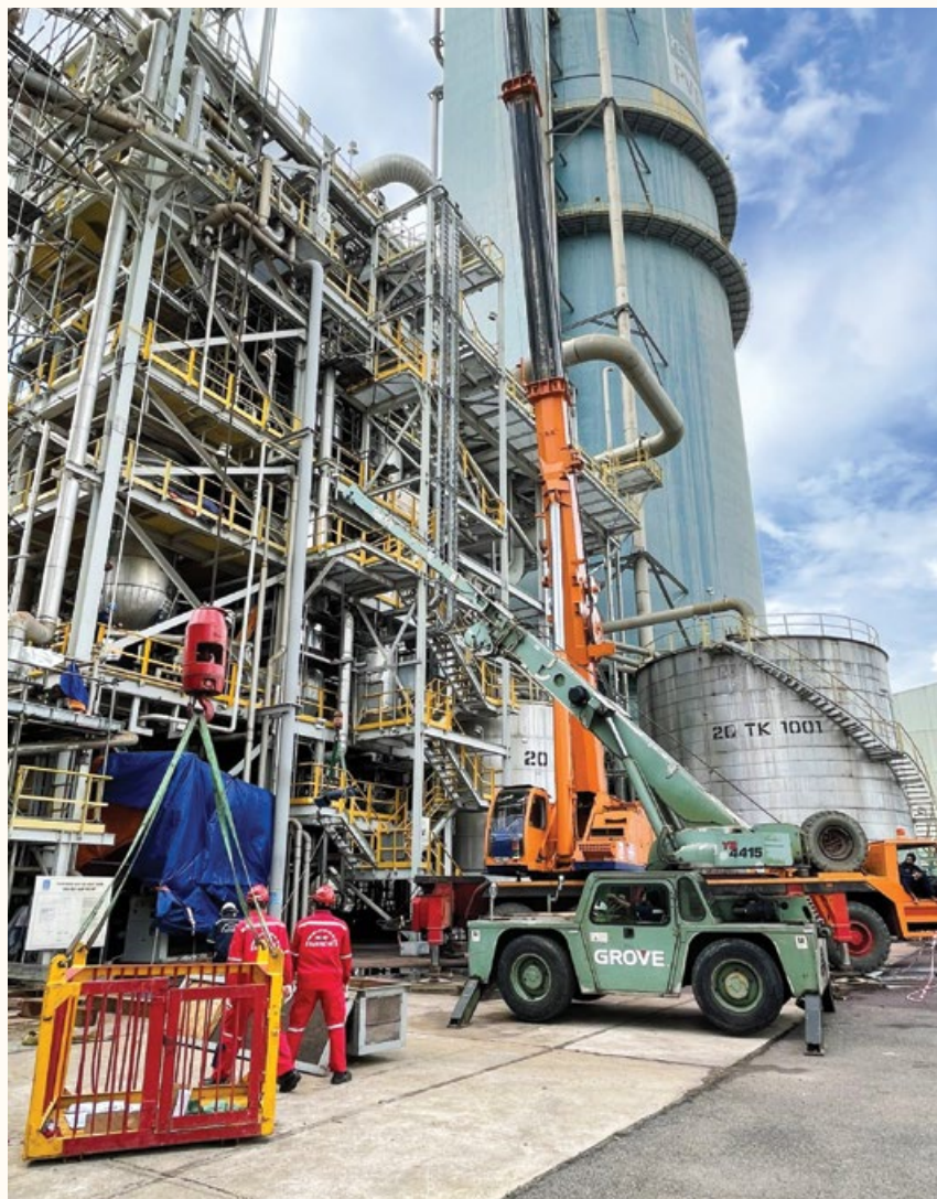
Trên công trường bảo dưỡng tổng thể Nhà máy Đạm Phú Mỹ
