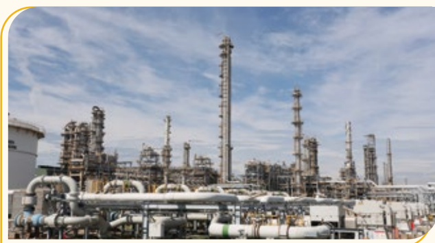
Một góc Nhà máy Lọc dầu Dung Quất
