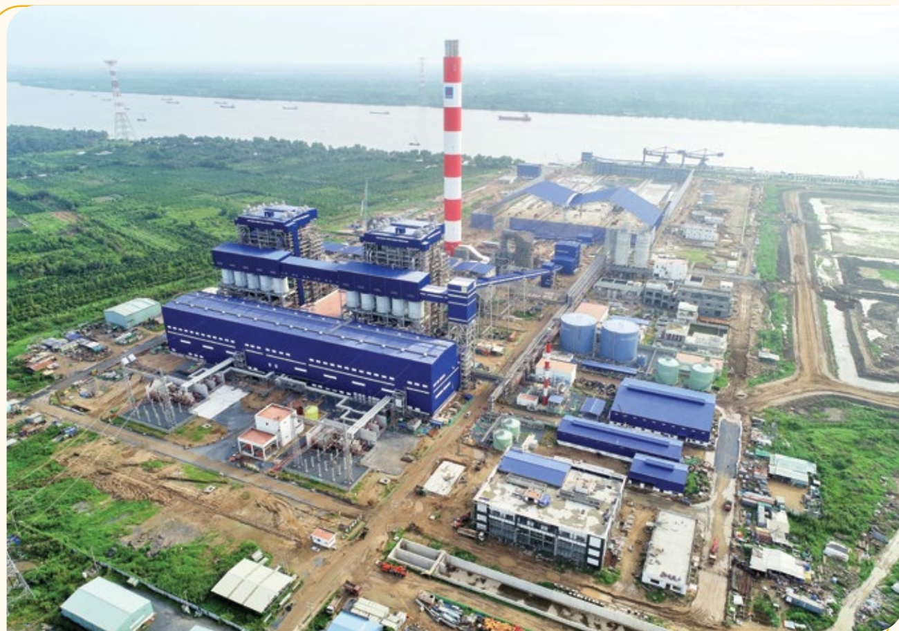
Toàn cảnh Nhà máy Nhiệt điện Sông Hậu 1
