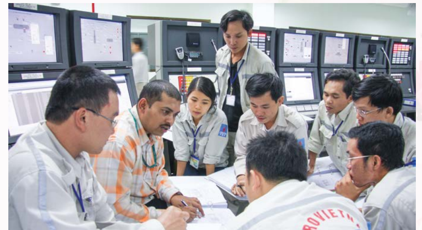
Nữ kỹ sư Phạm Minh Hòa được chuyên gia người nước ngoài hướng dẫn vận hành hệ thống điều khiển NMLD Dung Quất lúc chạy thử (commissioning)
