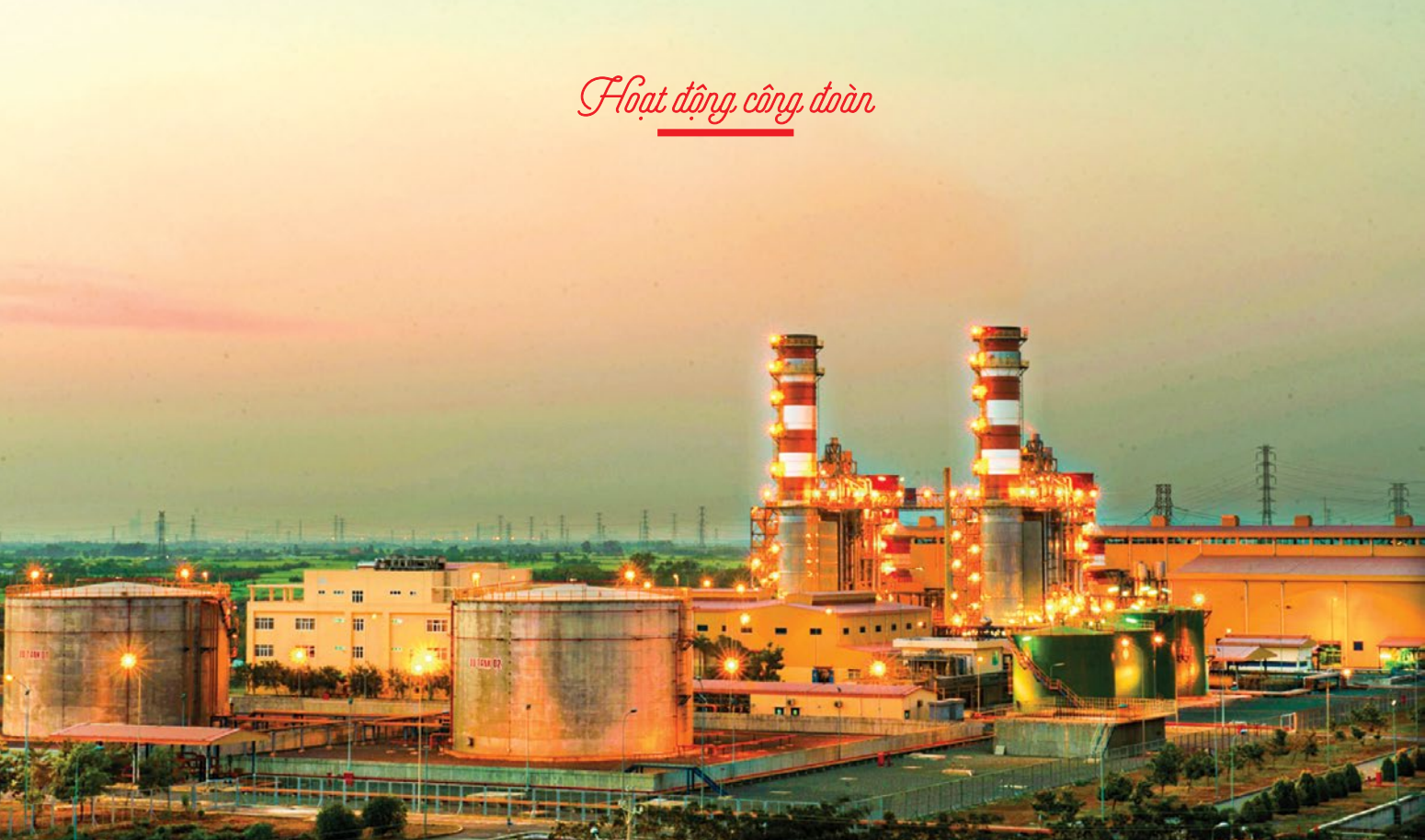
Nhà máy Điện Nhơn Trạch 2
